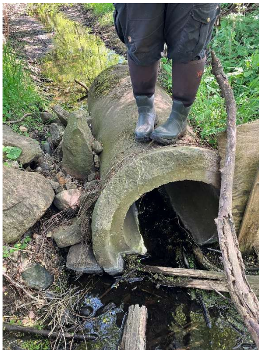
Figur 4-6: Eksisterende rørbro med tidligere interimistiske opstemnings plader.
