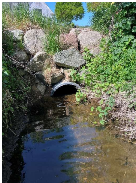
Figur 4-1: Eksisterende rørudløb i Ejlsmoserenden med tilhørende stensikring.
